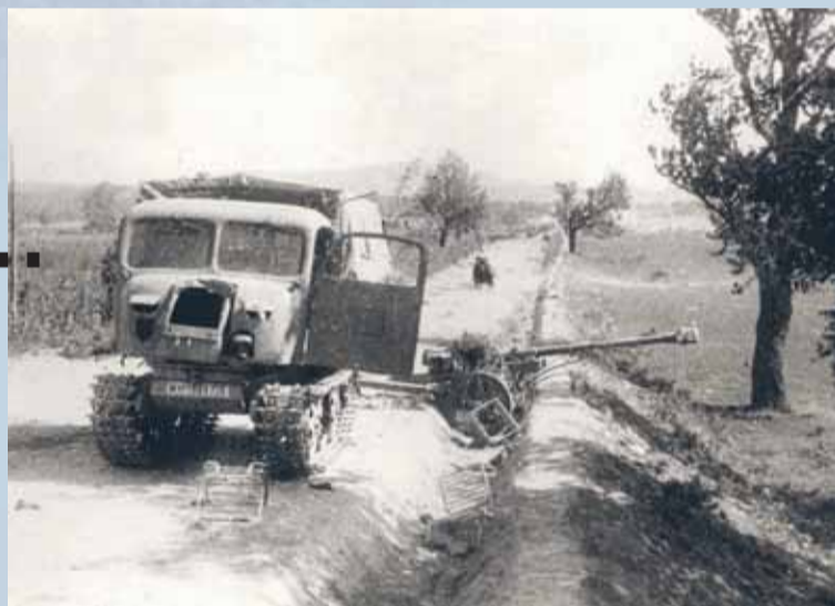
Produkowane w Austrii ciągniki Raupenschlepper Ost (RSO) na froncie wschodnim. (fot. Internet)
